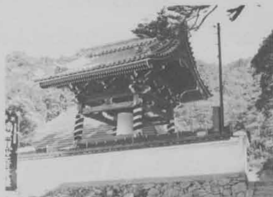
恒久平和を願って…普光寺鐘楼堂
