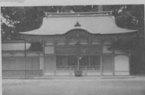
大原野素盞鳴神社竣工
